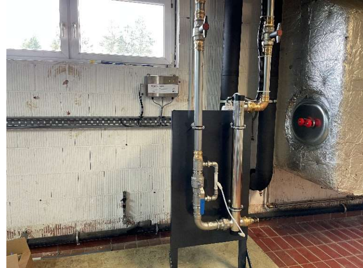
16) ULTRA V150/ O3-V4A – August 2022, Ozonbildende UV-Anlage mit 150W für die Desinfektion von teilweise trübem Kreislaufwassers eines Luftwäschers.
